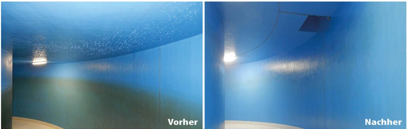
**Bild 1:** Durch Reinigung mit geeigneten Spezialprodukten werden Biofilme und Oberflächenbeläge im Trinkwasserbehälter effektiv entfernt
